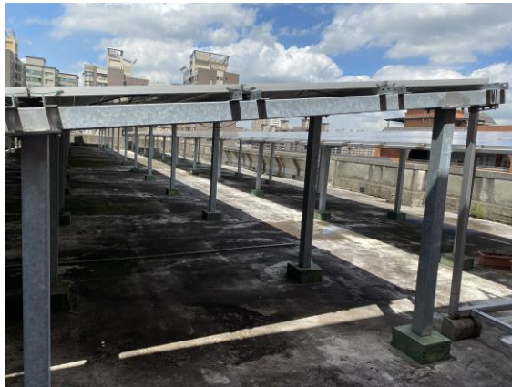
頂樓進行隔熱塗料，降低溫度
