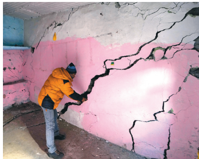
▲喬希馬特的建築蓋在土石流和地震過後的鬆軟地基，導致房屋逐漸下沉，建築體嚴重龜裂，整座聖城宛如一顆不定時炸彈。
