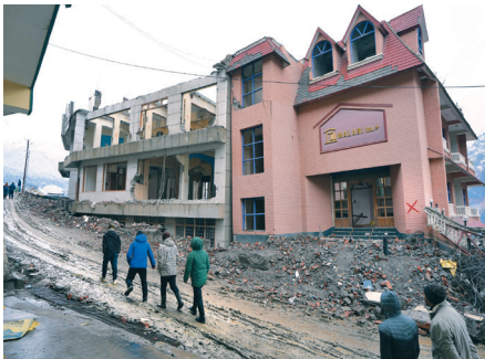
▲喬希馬特的建築蓋在土石流和地震過後的鬆軟地基，導致房屋逐漸下沉，建築體嚴重龜裂，整座聖城宛如一顆不定時炸彈。
